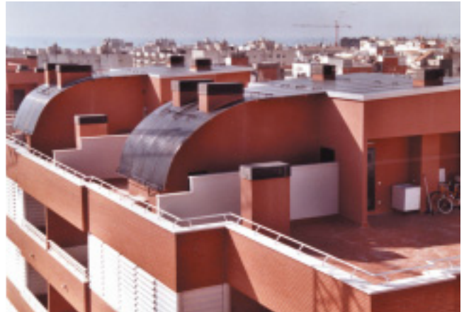
Cubierta Solar curvada de Vilanova (Barcelona, España) (Foto: Energie Solaire Hispano Swiss SA)
