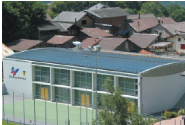
La Cubierta Solar del polideportivo de Varen (Suiza) (Foto: Energie Solaire SA)
