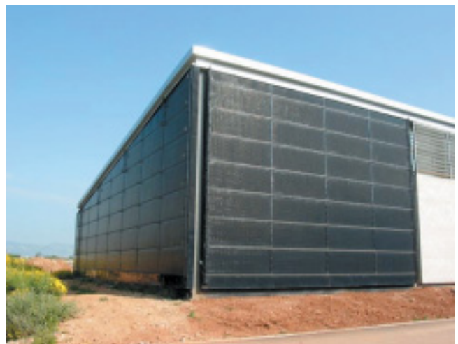
Planta de secado de Palma de Mallorca (España) (Foto: Energie Solaire SA)
