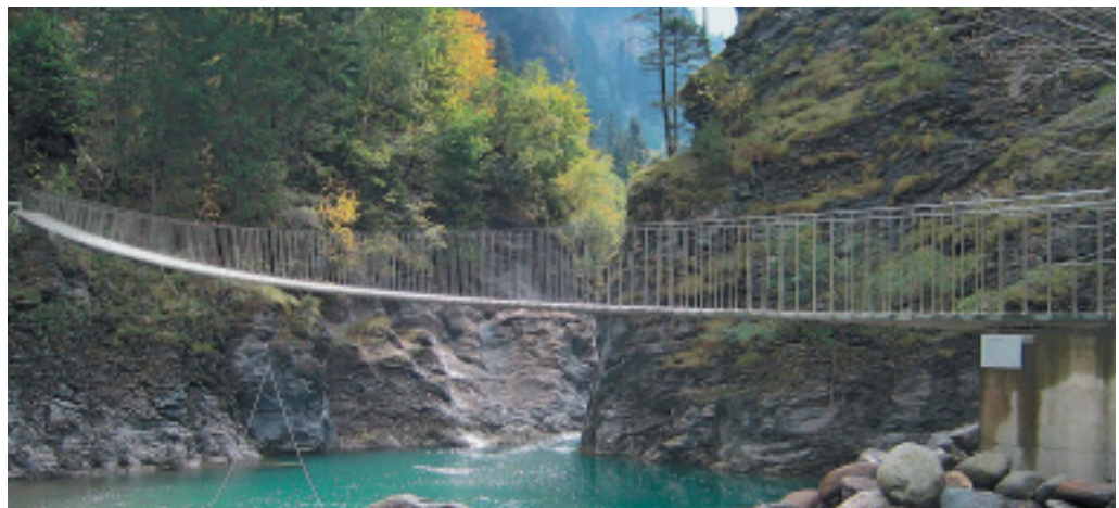
Cuatro cables finos de acero inoxidable y una pasarela de losas de piedra natural continúan el sendero a través del barranco de 40 metros.
