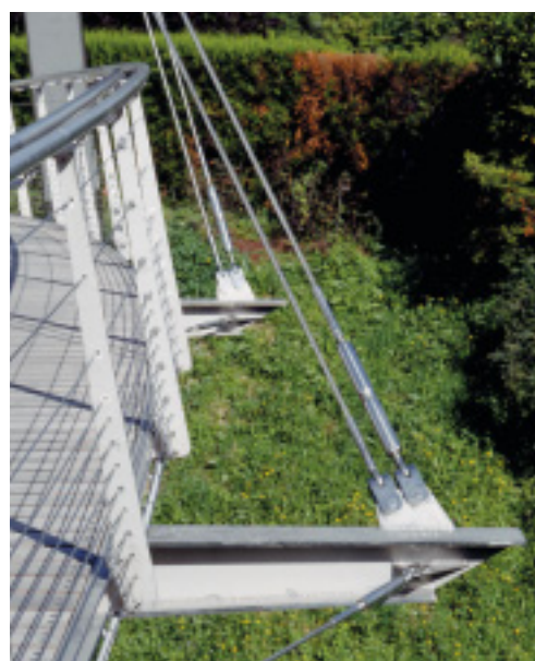
Pares de tirantes que unen las vigüetas transversales con el arco.
