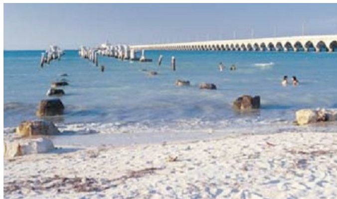
Figura 2. El muelle funcional en Progreso, México fue construido con varillas de acero inoxidable entre 1939 y 1941 y aún se encuentra en excelentes condiciones. El muelle caído fue construido con varilla de acero al carbono en 1969.
