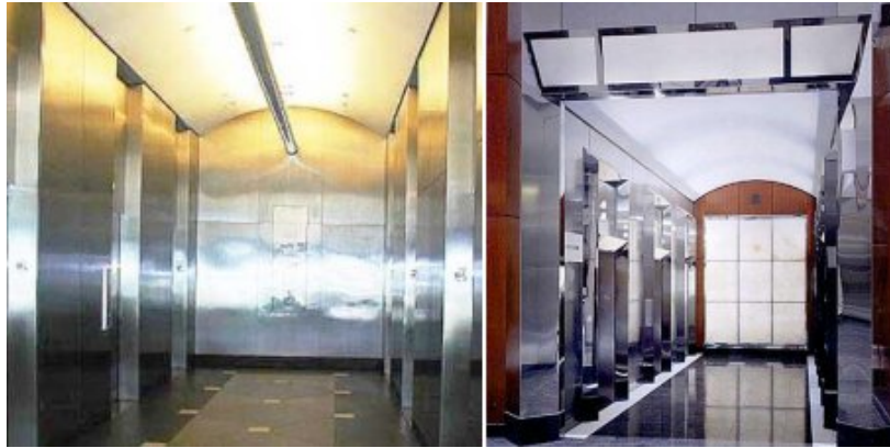
Figuras 6 y 7: Los paneles de acero inoxidable en el vestíbulo del 525 William Penn Place en Pittsburg se llegaron a ensuciar y tener ralladuras después de cincuenta años de uso. Durante la renovación del vestíbulo del 525 William Penn Place, los paneles de acero inoxidable de 50 años de antigüedad fueron retirados, limpiados, re-acabados y reutilizados. (Crédito de la fotografía: Catherine Houska, TMR Consulting e IKM Inc.)
