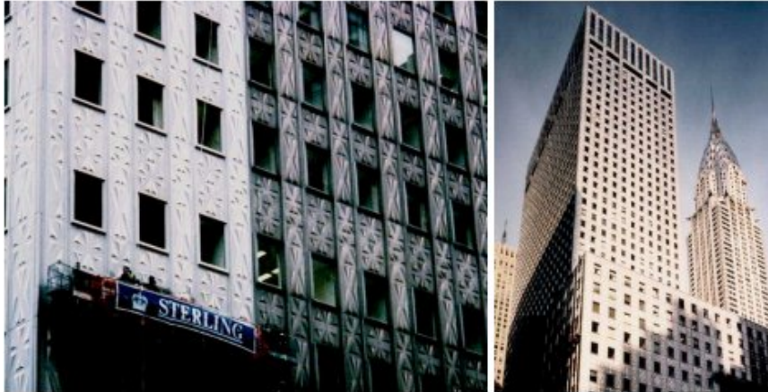
Figuras 4 y 5. En 1995, la limpieza del Edificio Chrysler alentó a los propietarios del edificio adyacente de la calle 150 East 42 nd Street para eliminar cuarenta y un años de suciedad. Ambos edificios fueron limpiados con una solución suave detergente, desengrasantes y agua y, donde fue necesario, un abrasivo fino que no rayara. Ambos edificios, el Chrysler y el 150 East 42 nd Street fueron restauradas a su brillante apariencia original. Ningún químico peligroso fue requerido. (Fotografías cortesía de Alleghen Teccnologies).
