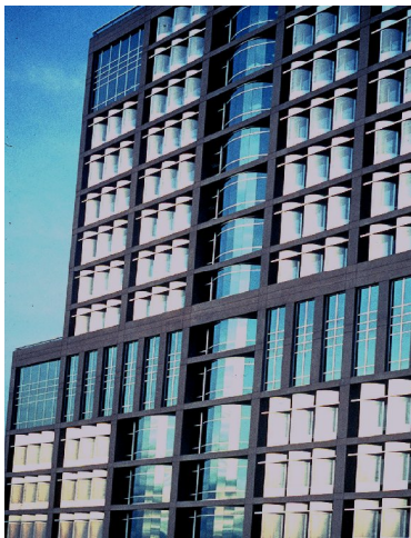
Figura 3 Las pantallas de las ventanas de acero inoxidable perforado y pulido en el Ayuntamiento de Phoenix redujeron dramáticamente los costos de aire acondicionado y mejoraron la comodidad del trabajador. (Fotografía cortesía de Allegheny Technologies).
