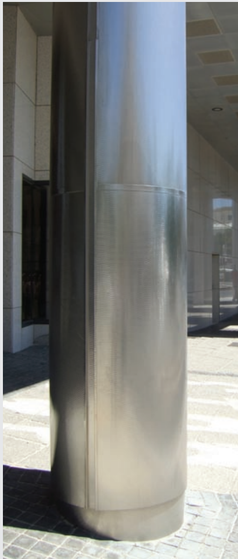
El acero inoxidable texturizado asegura superficies niveladas y enmascara de forma eficaz las posibles mellas.
