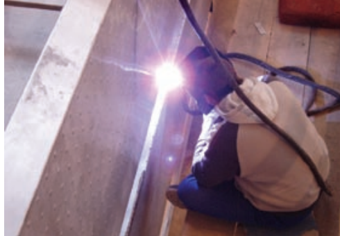
Soldadura en obra de la estructura de acero inoxidable de una piscina.
