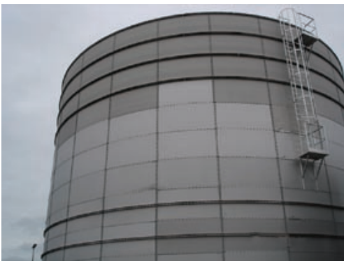
La combinación de láminas de metal de lotes diferentes puede implicar cierta inconsistencia en la apariencia visual.
