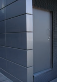
El efecto de rigidez en los bordes asegura planitud óptica.
