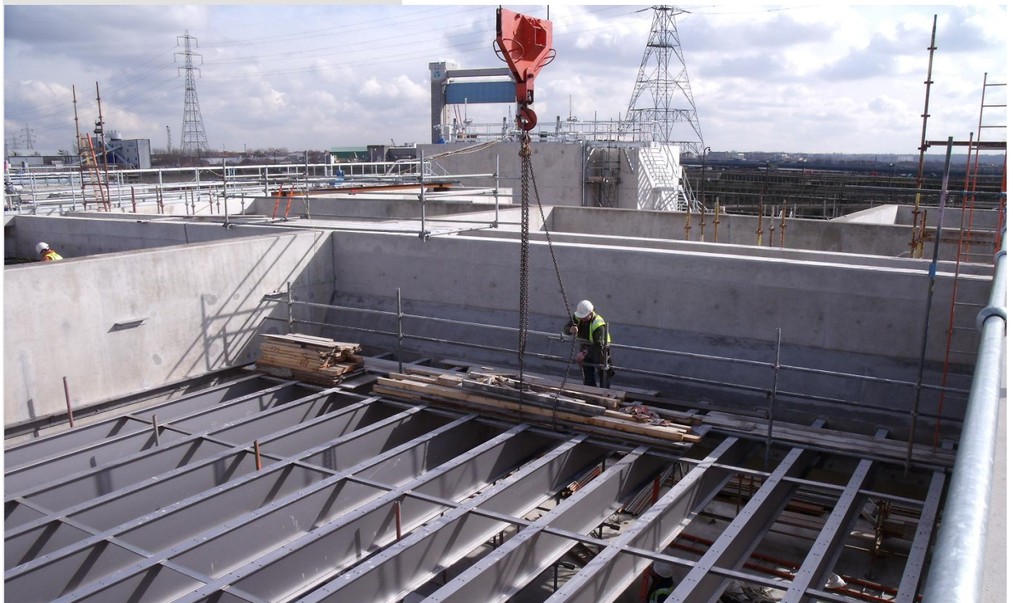
Figura 7: Estructura lamella terminada
