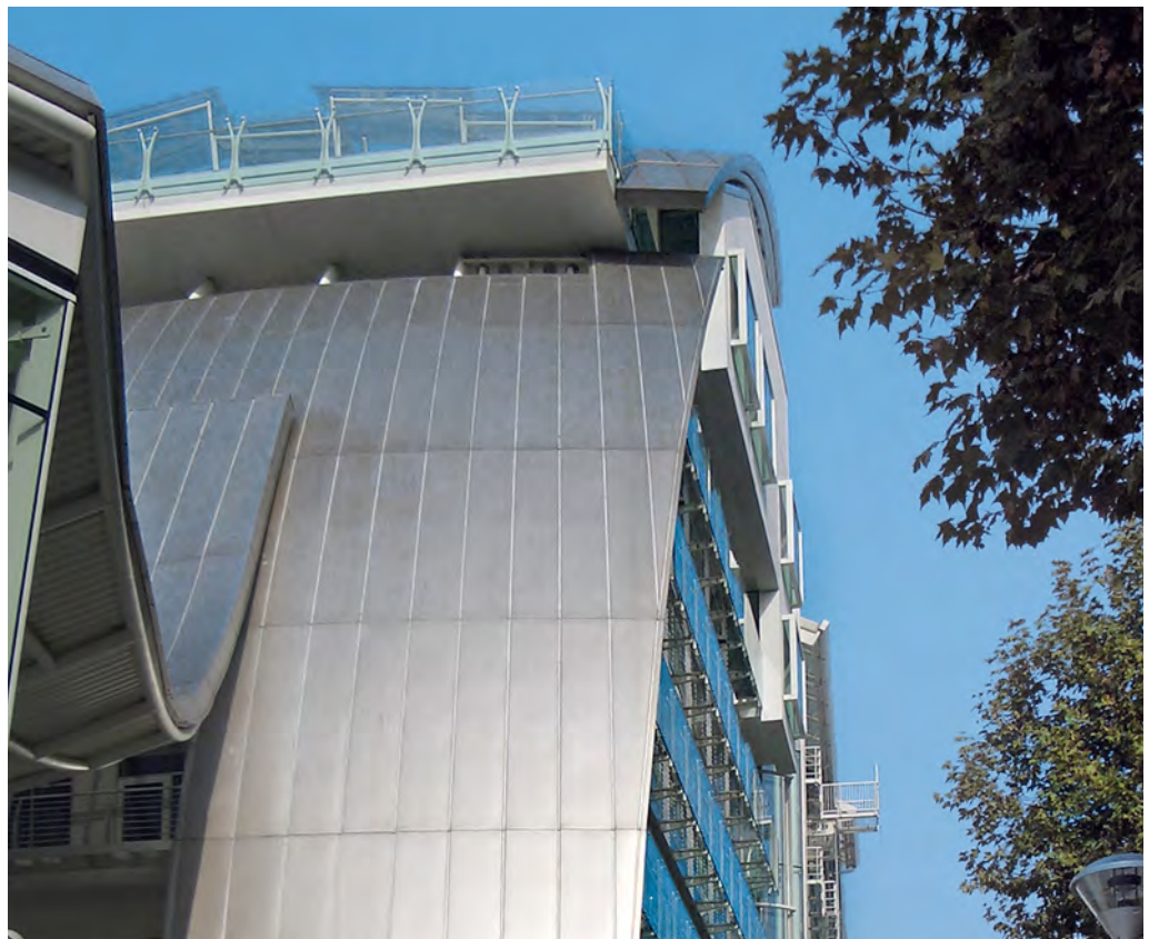
La lluvia provoca un efecto de limpieza natural en las partes de la envoltura del edificio expuestas a los elementos. Fotografía: Centro Inox, Milán (Italia).
