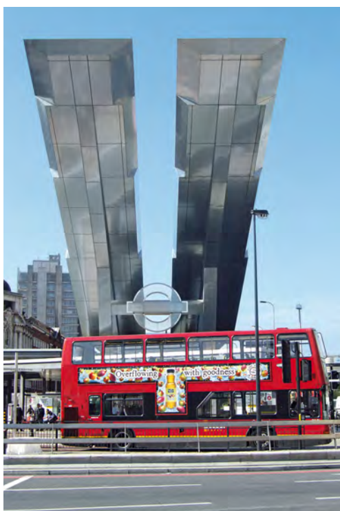
En la estación de autobuses Vauxhall Cross Bus Interchange, en Londres, se utilizó un acabado embossed con el fin de reducir las necesidades de limpieza.
