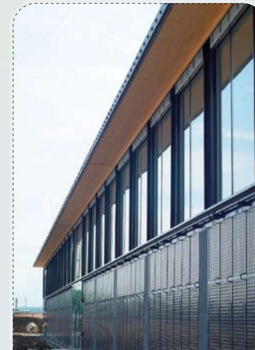
FIGURA 21: La superficie cromada en negro es eficiente como absorbedor de energía térmica, además de integrarse satisfactoriamente en cualquier entorno arquitectónico (Fotografía energie-solaire.com)
