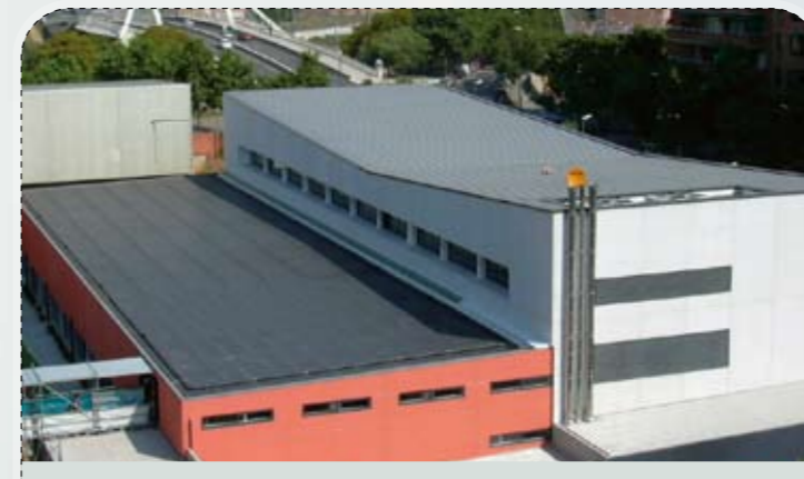
FIGURA 20: Los absorbedores pueden reemplazar totalmente a la lámina de tejado convencional (Fotografía: energie-solaire.com)
