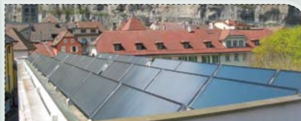
FIGURA 15: La eficiencia de los paneles acristalados es mayor cuando éstos están orientados hacia el sol del mediodía [Fotografía: energie-solaire.com]
