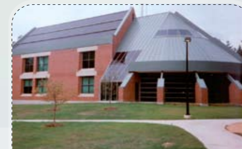
FIGURA 34: Tejado de acero inoxidable a dos aguas con módulos FV de silicio amorfo integrados y partes no activas (Fotografía: uni-solar.com)
