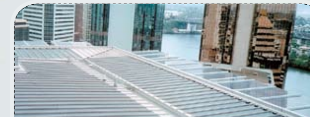
FIGURA 28: Tejado de acero inoxidable plano con células FV amorfas integradas (Fotografía: uni-solar.com)
