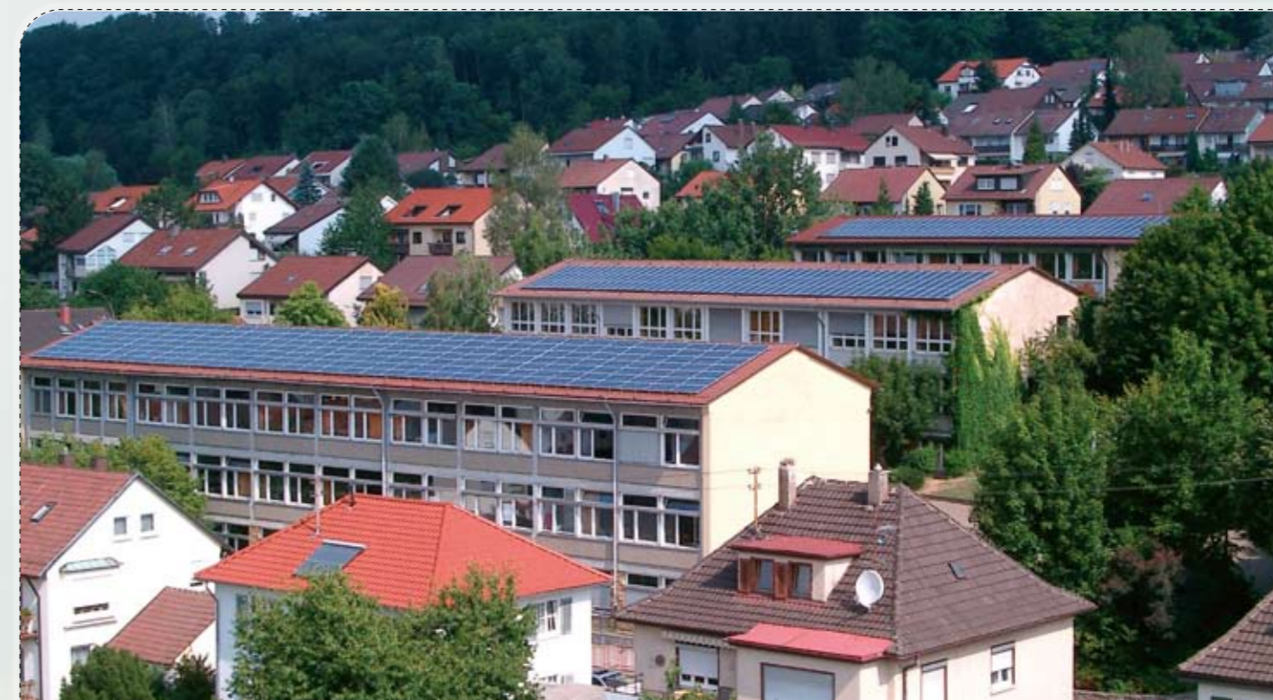
FIGURA 38: Paneles FV fijados a secciones de acero inoxidable (Fotografía: modersohn.de)
