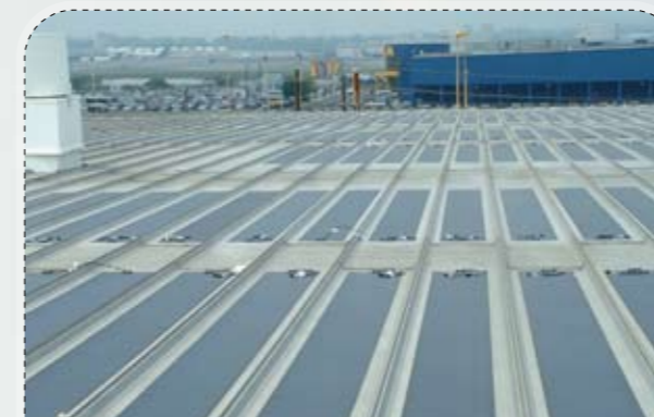
FIGURA 28: Tejado de acero inoxidable plano con células FV amorfas integradas (Fotografía: uni-solar.com)
