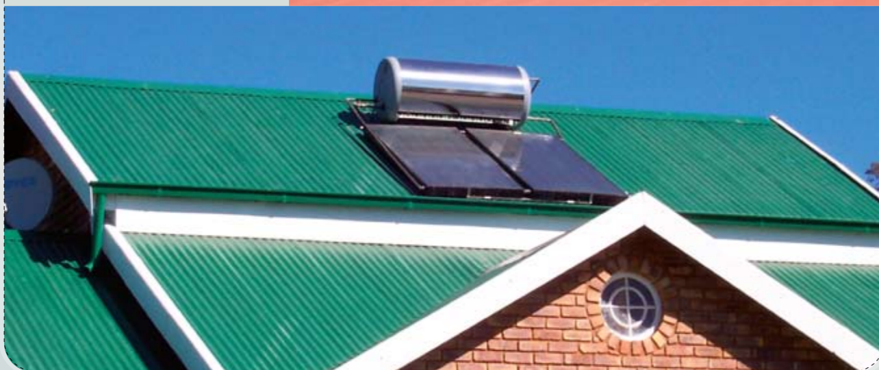
FIGURA 5: Las calidades de acero inoxidable de más alta aleación también son resistentes a las atmósferas costeras. Los ejemplos mostrados están situados en emplazamientos próximos a la costa atlántica [Fotografía: suntank.com]
