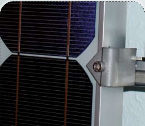
FIGURA 40: El acero inoxidable dúplex (23% cromo / 4% níquel) es una opción eficaz respecto a los costes en las partes que necesitan un elevado índice de seguridad (Fotografía: modersohn.de)
