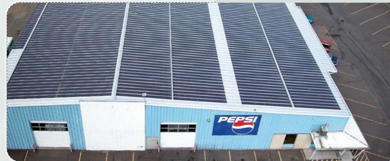
FIGURA 30: Edificio de uso comercial con un tejado prácticamente plano cubierto con unidades FV de acero inoxidable multifuncionales. La potencia de salida eléctrica es de aproximadamente 150 kW. La producción de electricidad anual en un clima soleado puede alcanzar 300.000 kWh/año (Fotografía: uni-solar.com)
