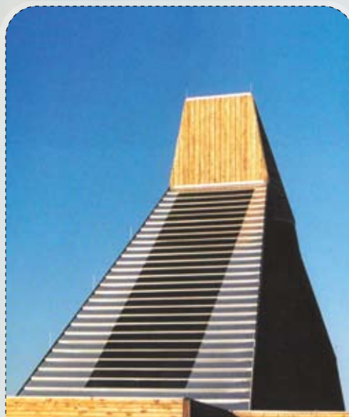
FIGURA 31: El tejado de acero inoxidable inclinado del edificio de un museo con módulos fotovoltaicos integrados (Fotografía: thyszen-solartec.com)
