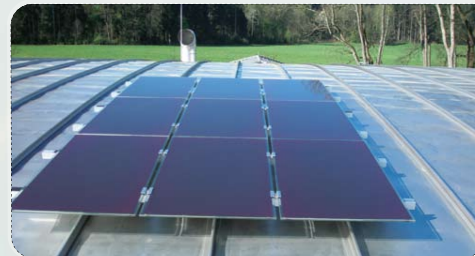
FIGURA 36: En las partes planas del tejado, en las que la lluvia no desagua con facilidad, la opción de acero inoxidable con soldadura continua es la única solución metálica posible (Fotografía: protectum.be)
