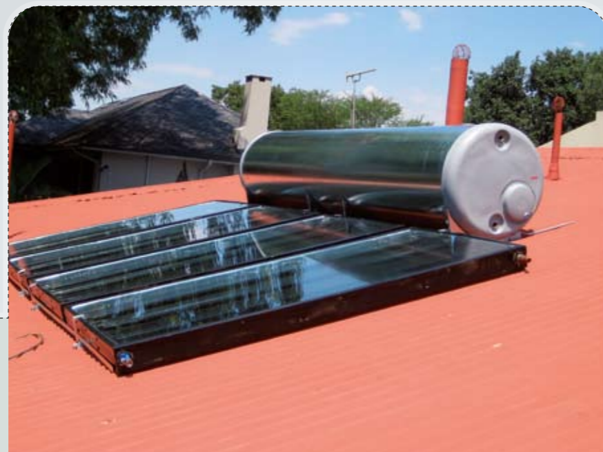
FIGURA 5: Las calidades de acero inoxidable de más alta aleación también son resistentes a las atmósferas costeras. Los ejemplos mostrados están situados en emplazamientos próximos a la costa atlántica [Fotografía: suntank.com]
