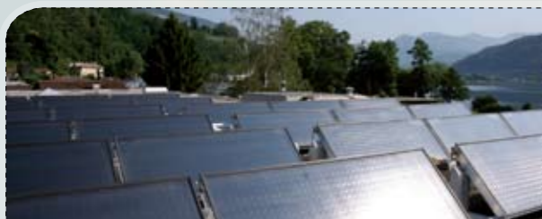
FIGURA 14: Los absorbentes de tipo laminar de acero inoxidable constituyen una solución técnica y financiera favorable para los paneles termosolares acristalados [Fotografía: energie-solaire.com]
