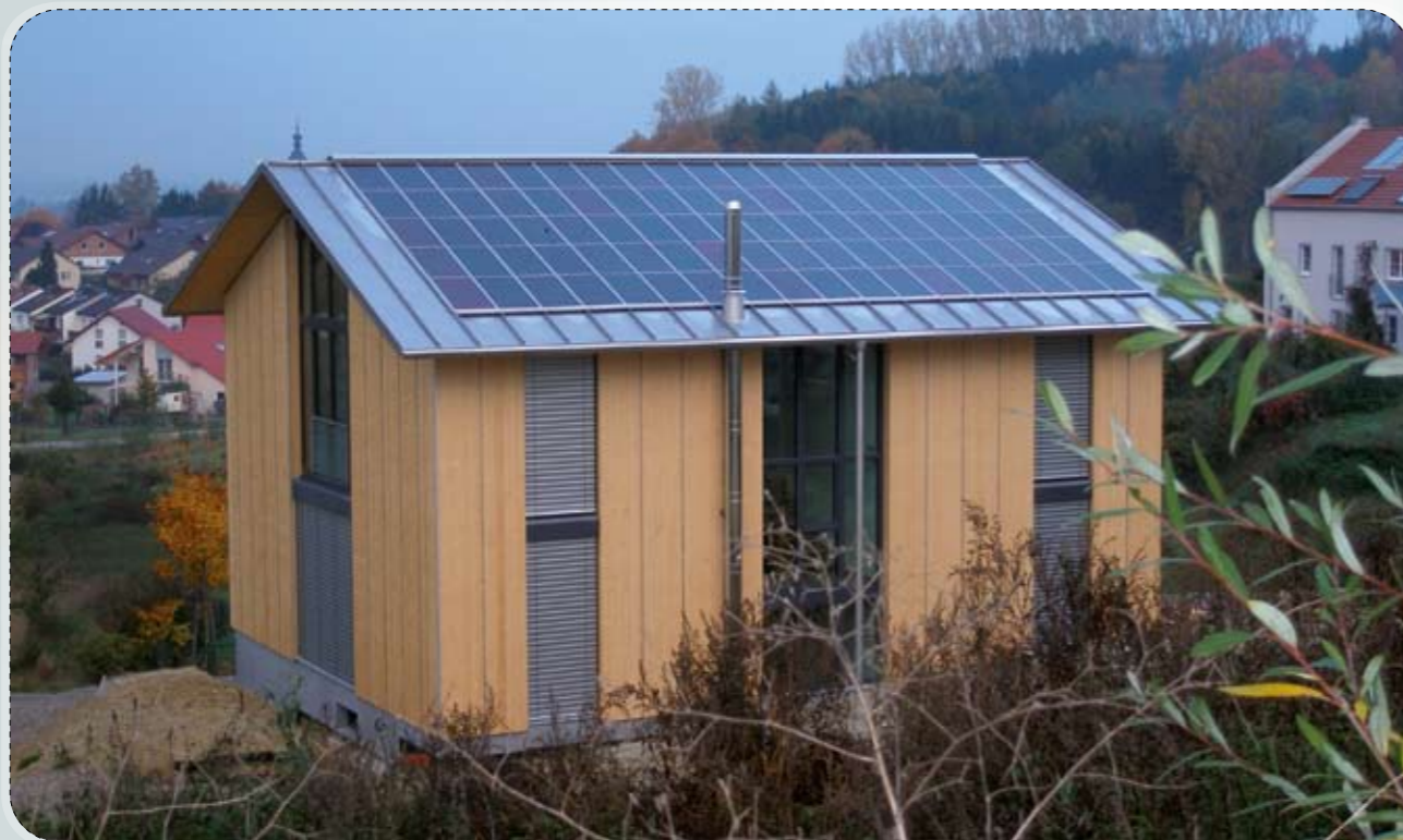
FIGURA 37: Los sistemas de tecnología solar y acero inoxidable integrados pueden aplicarse a edificios de cualquier tipo y tamaño (Fotografía: protectum.de)
