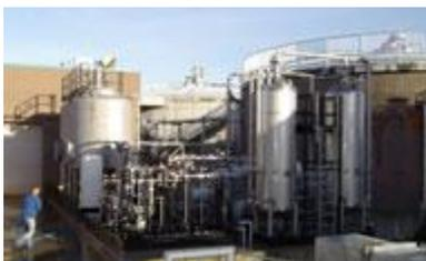
El sistema de biogás en Dublin, California, E. U. hace funcionar una planta de tratamiento de aguas residuales. La planta pesa 13,000 kilogramos, dos tercios de los cuales son acero inoxidable, y genera alrededor de 600 kilovatios de electricidad.
