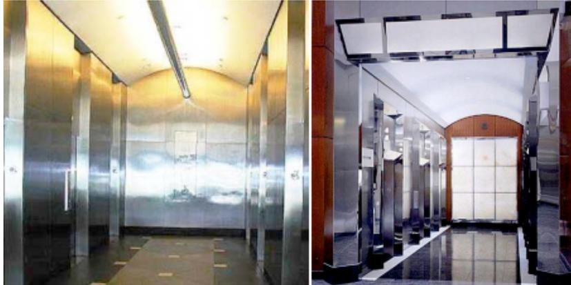
Figuras 6 y 7: Los paneles de acero inoxidable en el vestíbulo del 525 *William Penn Place* en Pittsburgh se llegaron a ensuciar y tener ralladuras después de cincuenta años de uso. Durante la renovación del vestíbulo del 525 *William Penn Place*, los paneles de acero inoxidable de 50 años de antigüedad fueron retirados, limpiados, re-acabados y reutilizados. (Crédito de la fotografía: Catherine Houska, TMR Consulting e IKM Inc.)
