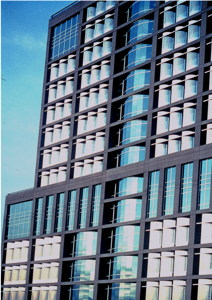
Figura 3 Las pantallas de las ventanas de acero inoxidable perforado y pulido en el Ayuntamiento de Phoenix redujeron dramáticamente los costos de aire acondicionado y mejoraron la comodidad del trabajador. (Fotografía cortesía de Allegheny Technologies).
