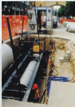
Instalación de tramo de tubería utilizando la tecnología de trincheras, en Turín.
