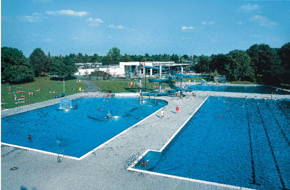
Figura 8: Esta alberca en Munich, Alemania fue revestida nuevamente con paneles de acero inoxidable tipo 316 que fueron soldados juntos. Fotografía cortesía de EuroInox .
