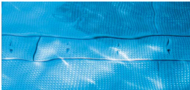
Figuras 12 y 13: Las canaletas de la alberca de tipo 316 y las aperturas de chorro de agua en las placas del piso. Fotografías cortesía de Martina Heizel.
