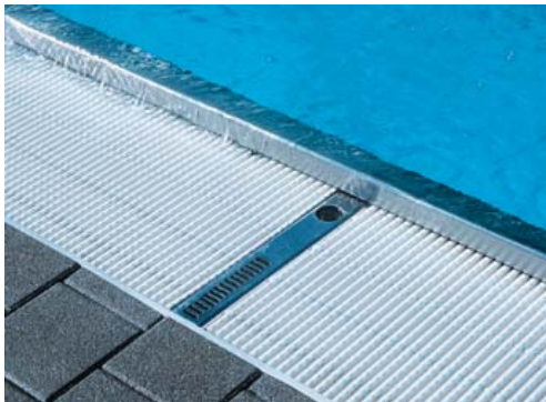
Figuras 12 y 13: Las canaletas de la alberca de tipo 316 y las aperturas de chorro de agua en las placas del piso. Fotografías cortesía de Martina Heizel.
