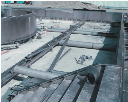
Figuras 10 y 11: El revestimiento, escaleras y tubos de agua nuevos de tipo 316 son mostrados en varias etapas de la construcción. Las paredes de acero inoxidable independientes crean la característica de agua "río lento". Fotografías cortesía de EuroInox .
