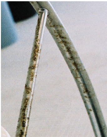
Figura 4: Este carrito de acero al carbono chapado en cromo para sujetar los marcadores de los carriles solamente ha estado en uso por unos pocos años pero ya hay corrosión considerable bajo el chapado. Fotografía cortesía de TRM Consulting .
