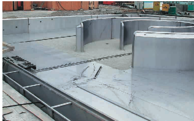
Figuras 10 y 11: El revestimiento, escaleras y tubos de agua nuevos de tipo 316 son mostrados en varias etapas de la construcción. Las paredes de acero inoxidable independientes crean la característica de agua "río lento". Fotografías cortesía de EuroInox .
