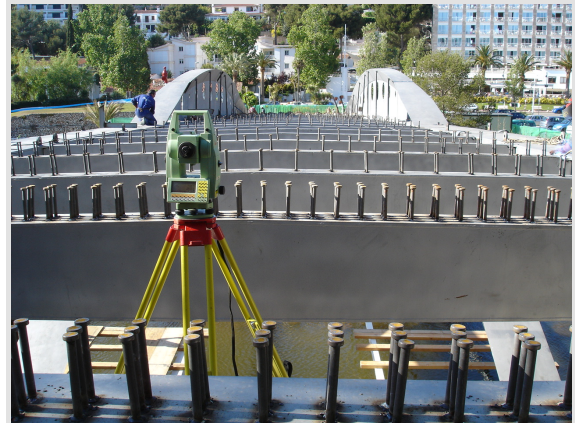
Figura 12: Conectores de corte sobre las vigas transversales
