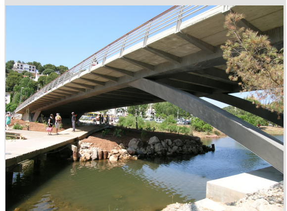
Figura 2: Conexión arco – viga longitudinal
