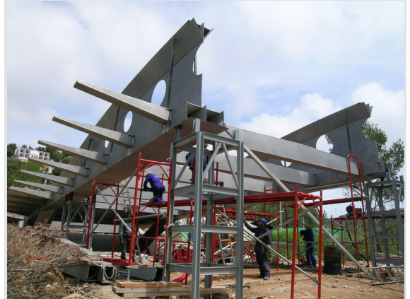
Figura 11: Soportes temporales para la estructura principal
