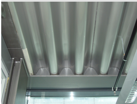
Figura 7: Detalle de esquina de la cubierta perfilada
