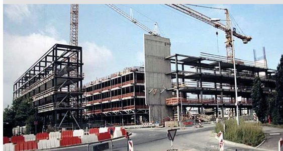
Figura 9: Montaje de la estructura de acero estructural
