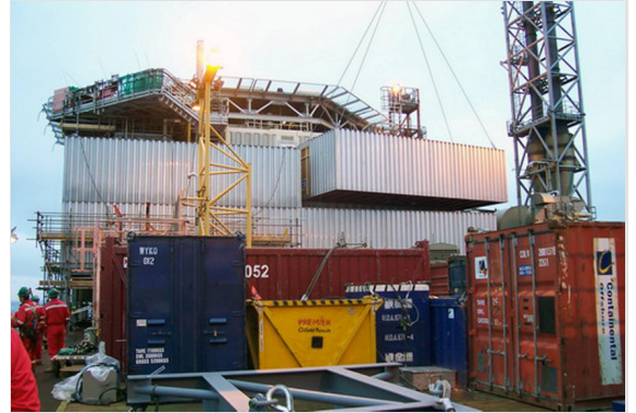
Figura 9: Instalación de un módulo habitacional
