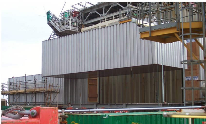
Figura 2: Instalación del módulo final a bordo de la Plataforma Armada
