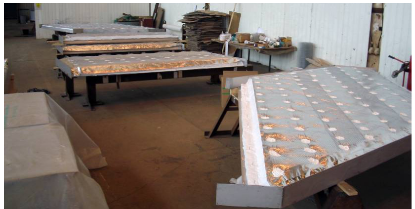
Figura 7: Aislante colocado en el interior de las paredes del panel
