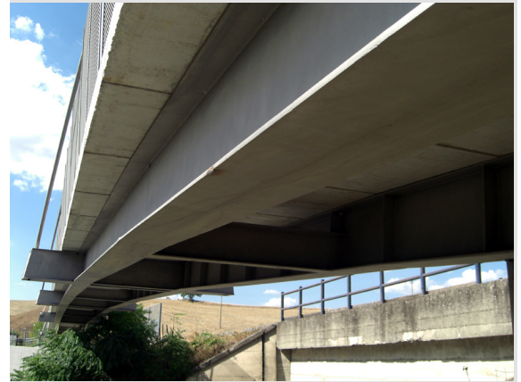
Figura 2: Parte inferior del puente en donde se aprecian las barras longitudinales y transversales que dan soporte a la cubierta
