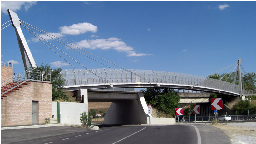
Figura 3: Vista desde la autopista del puente finalizado
