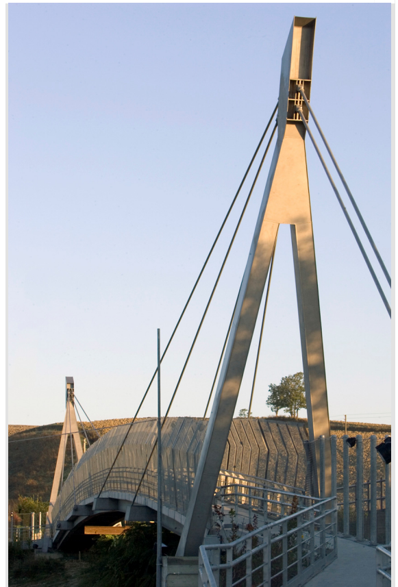
Figura 1: Vista que tiene el peatón del puente terminado
