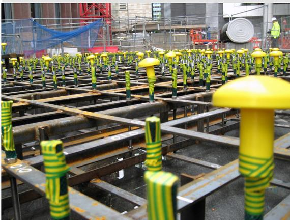
Figura 6: Separador de los pernos antes del vertido del concreto
