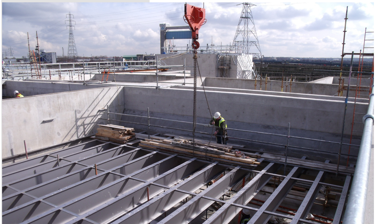
Figura 7: Estructura lamella terminada
