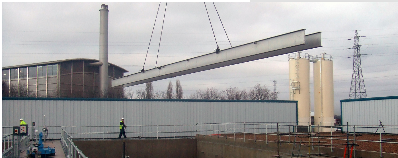
Figura 8: Instalación de un par de columnas principales
