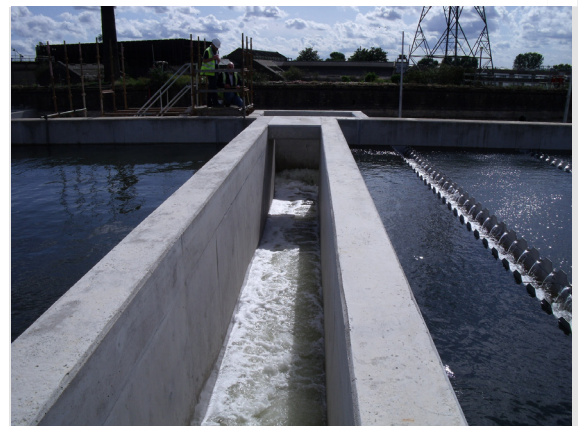
Figura 1: Planta de desalinización
