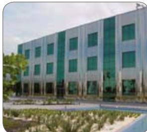
Tipo 1.4521/444 cepillado N° 4 (paneles horizontales), Edificio Vivo, Río De Janeiro, Nucleo Inox, Brasil (entorno costero)
