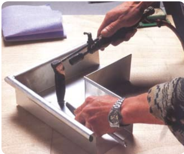
Soldadura de un canalón, tipo 430Ti revestido de estaño
