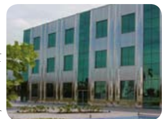
Revestimiento de edificio, tipo 444, Brasil.
