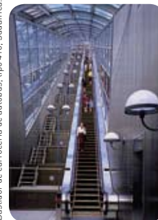
Escalera mecánica, tipo SUS301, Japón.
