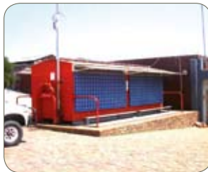
Tipo 1.4003/410, pintado, SASSDA, Sudáfrica. Los ferríticos se suelen pintar por cuestiones estéticas.
