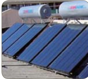
Tipo 1.4509/441 (cilindro), Sun Sank y SASSDA, Sudáfrica
