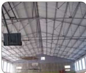
Soporte de tejados: una aplicación potencial para los ferríticos.
