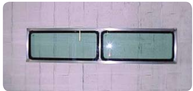
Ventanas fijadas mediante adhesivo a un marco tubular 1.4003.
