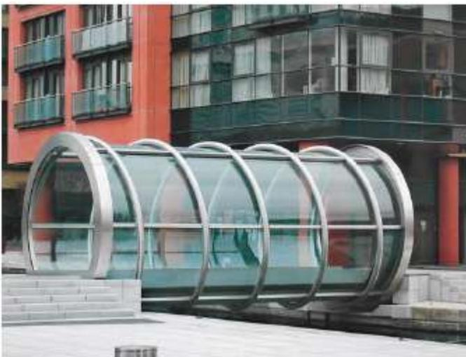
**Figura 16:** El puente helicoidal utiliza tipo 316 y vidrio para crear un puente peatonal movable. Fotografía cortesía de Christopher von der Howen.
