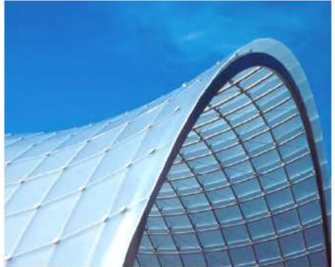
**Figura 20 A y B:** La concha acústica Schubert Club utilizó tipo 316 y vidrio para crear un diseño que es resistente a los altos vientos, la sal para deshielo de un puente carretero cercano y la inundación estacional. Fotografías cortesía de James Carpenter Design Associates y Shane McCormick.
