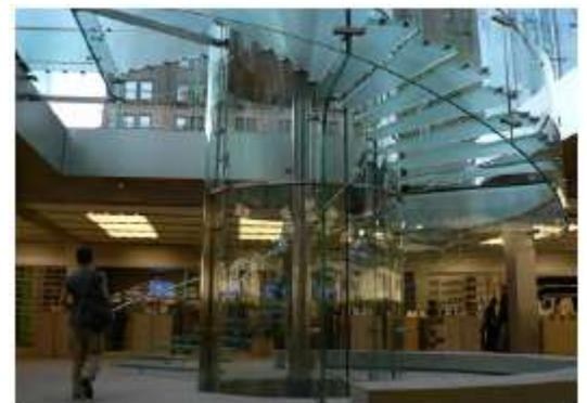
**Figura 19:** La escalera debajo del cubo de Apple utiliza dúplex 2205 de alta resistencia para afianzar los hilos de la escalera de vidrio y tipo 304 para los barandales y otros detalles. Fotografía cortesía de TriPyramid Structures, Inc. Fotógrafo Midge Eliassen
