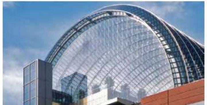
**Figura 21 A y B:** El Centro Kimmel es una estructura de red de cable unidireccional. El acero inoxidable tipo 316 ayudó a hacer este diseño posible. Fotografías cortesía de E. Dennis y Raphael Viñoly Architects.
