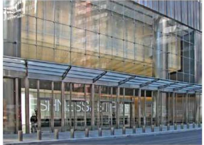
**Figura 15:** El 7 World Trade Center (7WTC) utiliza dúplex 2205 de alta resistencia para crear un vestíbulo abierto y transparente al mismo tiempo que se aumenta la seguridad personal. Fotografía cortesía de la Asociación Internacional del Molibdeno, Fotógrafa Catherine Houska
