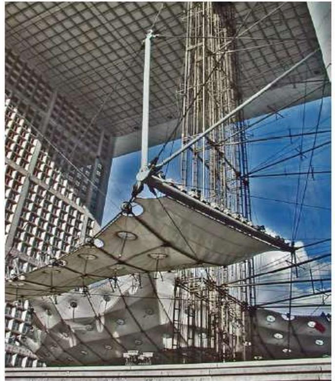
**Figura 14 A y B:** El increíble Gran Arco de París es posible por el uso del acero inoxidable dúplex de alta resistencia. Fotografía cortesía de la Asociación Internacional del Molibdeno, Fotógrafa Nicole Kinsman
