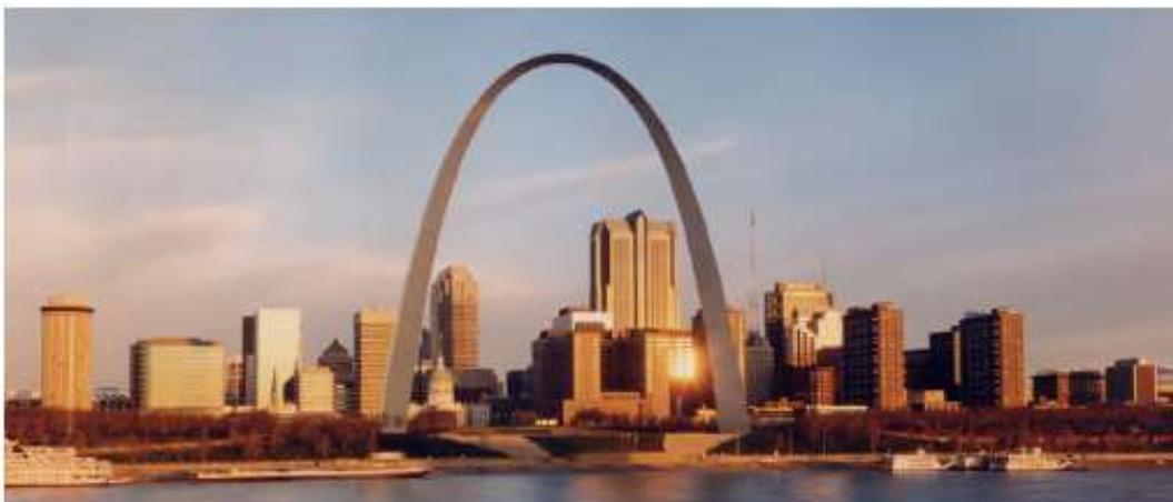
**Figura 1:** el Arco Gateway en Saint Louis, Missouri, EE.UU fue terminado en 1965 y está hecho de chapa soldada de 6.3 mm (0.25 in) de tipo 304. Fotografía cortesía del Servicio Nacional de Parques de EE.UU.
