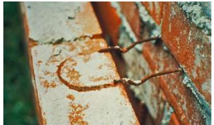
**Figura 13:** El terremoto de Newcastle, Australia en 1989 provocó que las paredes de mampostería colapsaran y la corrosión galvánica del amarre de la pared fue identificada como la causa de estas fallas. Fotografía cortesía de Noel Herbst.
