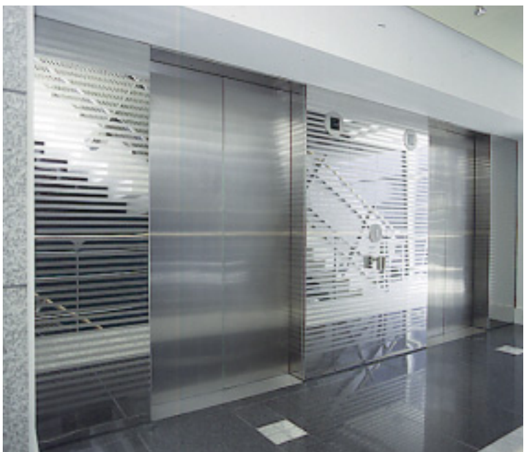
El uso de chapas alternando acabados mates y pulidos contrastan muy bien proporcionando un efecto sorprendente. Estas puertas de ascensor de un banco de Postdam, Alemania, son un buen ejemplo.
