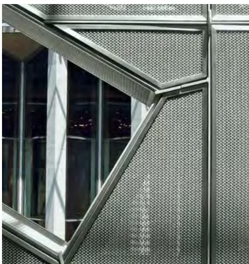
El extenso revestimiento de la pared en la Galería Nacional de Victoria, Melbourne, está realizada con malla de acero inoxidable sujeta a un marco perimetral.
