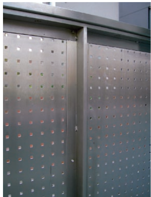
Las manchas localizadas de óxido fueron provocadas por partículas de hierro de un disco que había sido utilizado previamente sobre acero al carbono (izquierda). Si tiene lugar la contaminación férrica, puede ser eliminada mediante decapado en el propio lugar de la construcción (derecha) [12].
