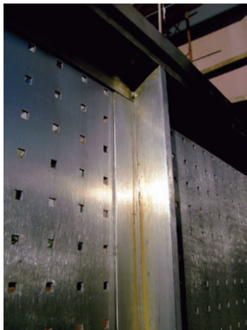
Las manchas localizadas de óxido fueron provocadas por partículas de hierro de un disco que había sido utilizado previamente sobre acero al carbono (izquierda). Si tiene lugar la contaminación férrica, puede ser eliminada mediante decapado en el propio lugar de la construcción (derecha) [12].
