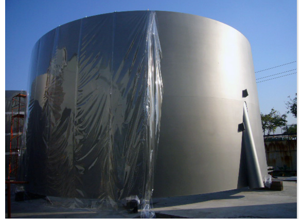
Figura 3: Segmento de la coraza en acero inoxidable
