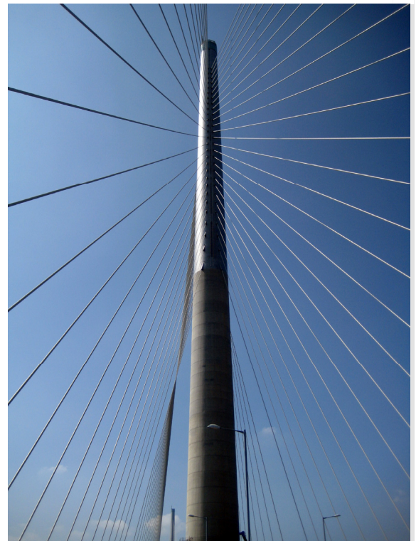
Figura 2: Torre y tirantes
