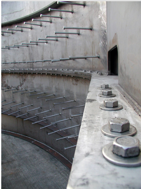
Figura 6: Conexión de los bordes de las pestañas
