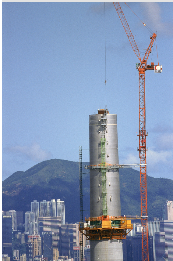
Figure 7: Instalación de los segmentos de la coraza de acero inoxidable.
