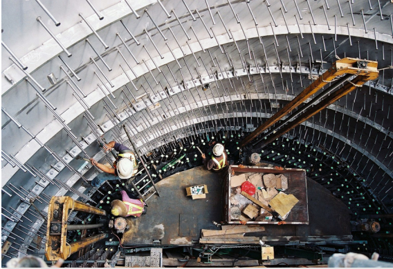
Figura 5: Conectores de corte en el interior de una sección de la torre
