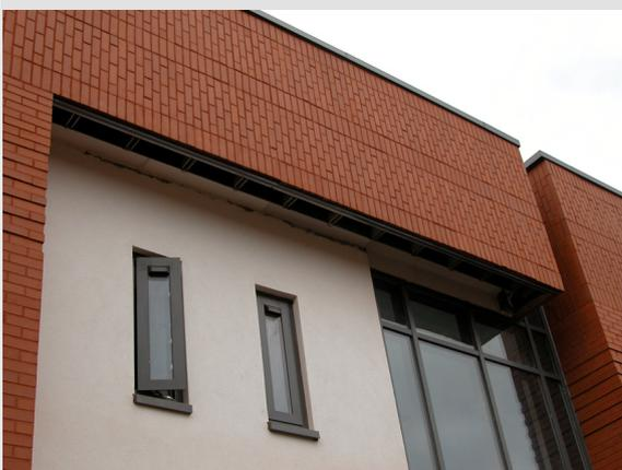
Figure 5: Construcción de la obra de albañilería unida verticalmente de forma apilada sostenida por el sistema de soporte de mampostería.
