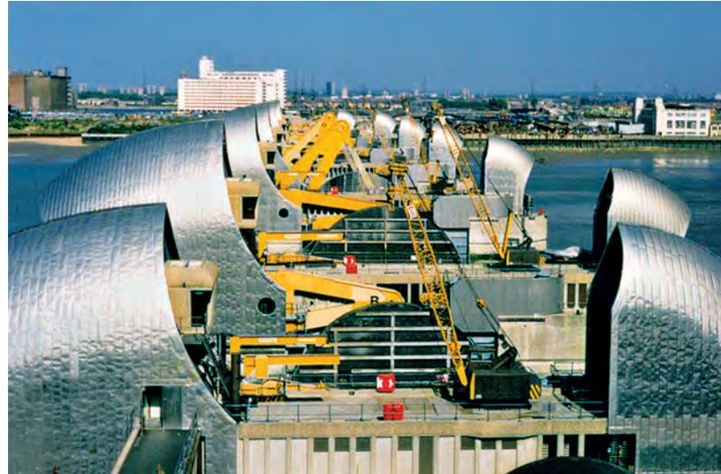
**Figura A** El reluciente acero inoxidable del tipo 316 de la barrera del Támesis poco después de ser abierta en 1982. (Fotografía cortesía del Instituto del Níquel)
