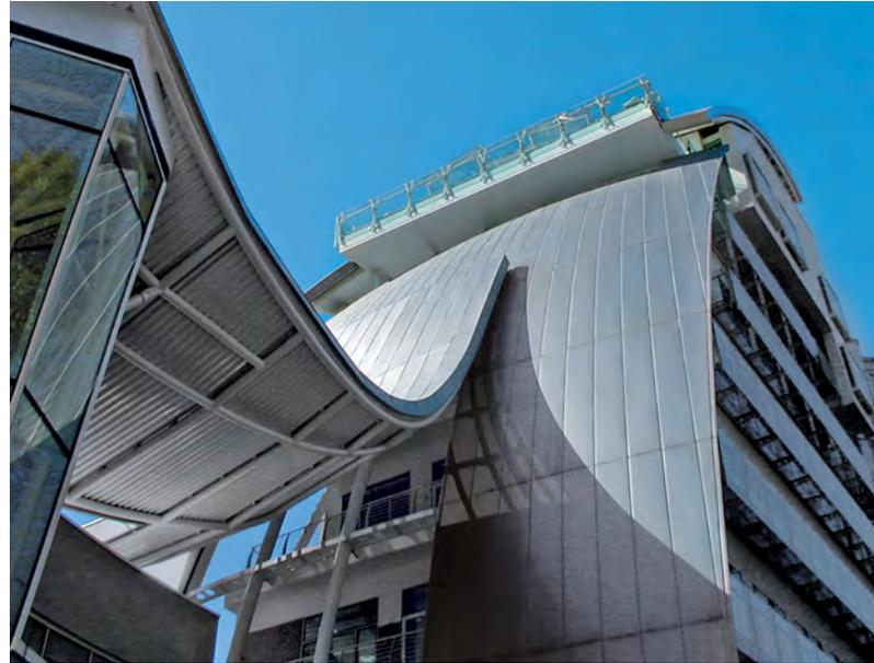
**Figura A** El nuevo edificio de oficinas tiene una "vela" perforada de acero inoxidable Tipo 316L de siete pisos que también sirve como protector solar. (Fotografía cortesía de Centro Inox)
