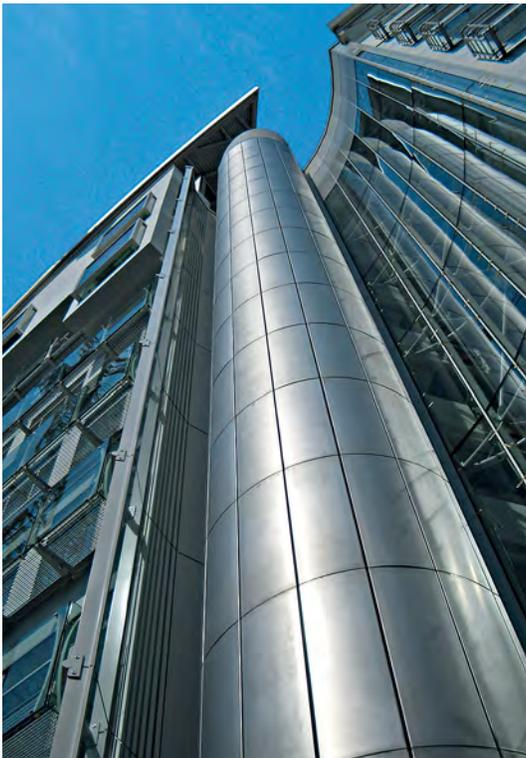
**Figure B** El acero inoxidable Tipo 316L cubre el hueco cilíndrico del elevador en el punto donde los edificios fueron unidos. (Fotografía cortesía de Centro Inox)
