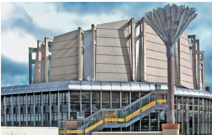
Figura B Esta fotografía de 2008 muestra el acero inoxidable Tipo 316 reluciente en el sol como resultado de la limpieza regular de mantenimiento. (Fotógrafo: Les Boulton, Fotografía cortesía del Instituto del Níquel)
