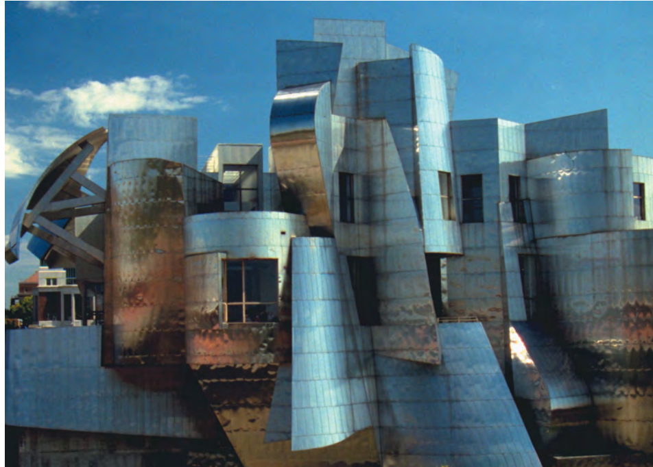
Figura A (arriba). Acero inoxidable 316 con un acabado superficial terso y un diseño que toma ventaja de la lluvia para naturalmente lavarse, fueron una buena elección para la construcción del Museo de Arte Weissman. Aún y cuando se localiza adyacentemente a un camino muy transitado donde se emplea sal para deshielar, no existen trazos de corrosión. El color del edificio cambia constantemente, reflejando el medio ambiente que lo rodea.
