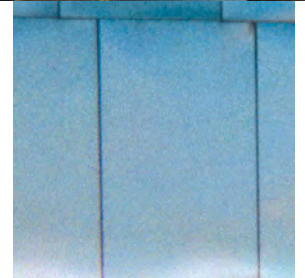
Figura A (arriba). Acero inoxidable 316 con un acabado superficial terso y un diseño que toma ventaja de la lluvia para naturalmente lavarse, fueron una buena elección para la construcción del Museo de Arte Weissman. Aún y cuando se localiza adyacentemente a un camino muy transitado donde se emplea sal para deshielar, no existen trazos de corrosión. El color del edificio cambia constantemente, reflejando el medio ambiente que lo rodea.
