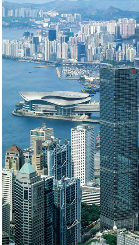
Figuras A y B El Centro Cheung Kong es la construcción más alta en el primer plano de la Figura A. La entrada y otros detalles son visibles en la Figura B. El acero inoxidable tipo 316 con acabado terso de la superficie fue una excelente selección debido a su exposición a la contaminación y a la sal de la costa. Los mecanismos de limpieza para las ventanas fueron construidos dentro del edificio para la fácil limpieza. Como se muestra en la Figura A, éste se encuentra en una cercana proximidad al puerto. (Fotografías Cortesía de Outokumpu)
