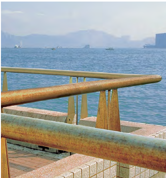
Figura C La salpicadura de agua de mar o el rocío corroerán el acero inoxidable tipo 316. El acabado superficial áspero en estos barandales y el lavado no frecuente empeoran el problema. (Fotografía Cortesía del Instituto del Níquel)
