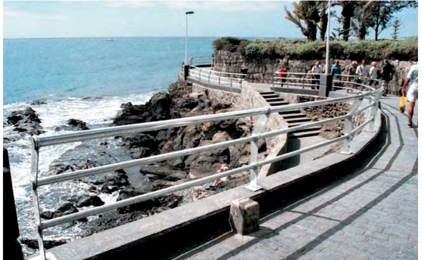
Figura A Esos barandales de acero inoxidable 2205 están expuestos al rocío de sal y a salpicaduras ocasionales. Están ubicados en la ciudad de San Augustin en las Islas Canarias. No ha habido manchado por corrosión a pesar de la exposición al rocío de sal. (Fotografía Cortesía de Outokumpu)
