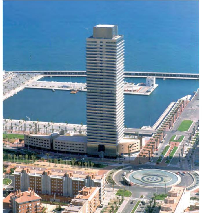
**Figura A** El acero inoxidable tipo 316 que reviste la Torre de oficinas Mapfre está separado del Mar Mediterráneo por un parque y un puerto deportivo. A pesar de la ubicación corrosiva, la apariencia del acero inoxidable es igual. (Fotografía cortesía de ACERINOX)
