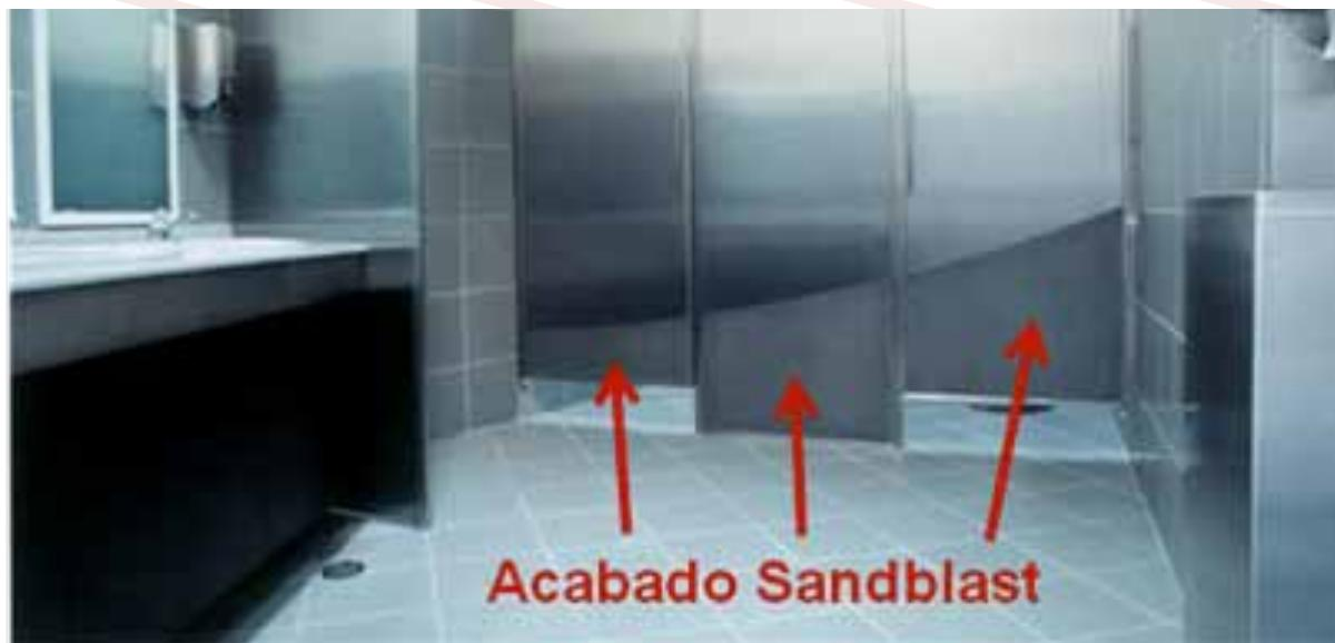
El chorreado con arena proporciona uniformidad, una superficie no direccional y de baja reflectividad que contrasta bien, visualmente, con los acabados pulidos. Consiste en la aplicación de materiales abrasivos con aire a presión que generan cambios en la superficie.
