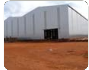
Tipo 1.4003, nueva nave de acabados de Columbus, Sudáfrica
