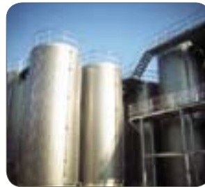
Tipo SUS430J1L, revestido de resina en color (camisa exterior), JSSA, Japón
