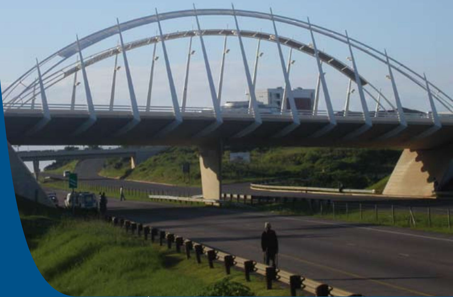
PUENTE SOBRE AUTOPISTA CON ESTRUCTURA DE ACERO INOXIDABLE FERRÍTICO PINTADO. DURBAN (SUDÁFRICA).
