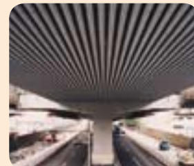
Paseo elevado con cubierta insonorizada, Japón
