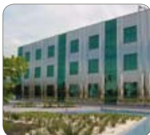
Tipo 1.4521/444 cepillado N° 4 (paneles horizontales), Edificio Vivo, Río De Janeiro, Nucleo Inox, Brasil (entorno costero)
